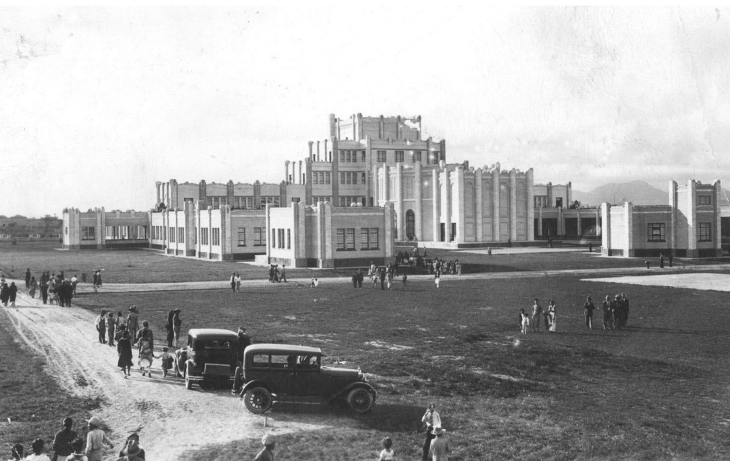
Vista posterior del edificio. 1933. Fototeca del Archivo Municipal de Saltillo.
