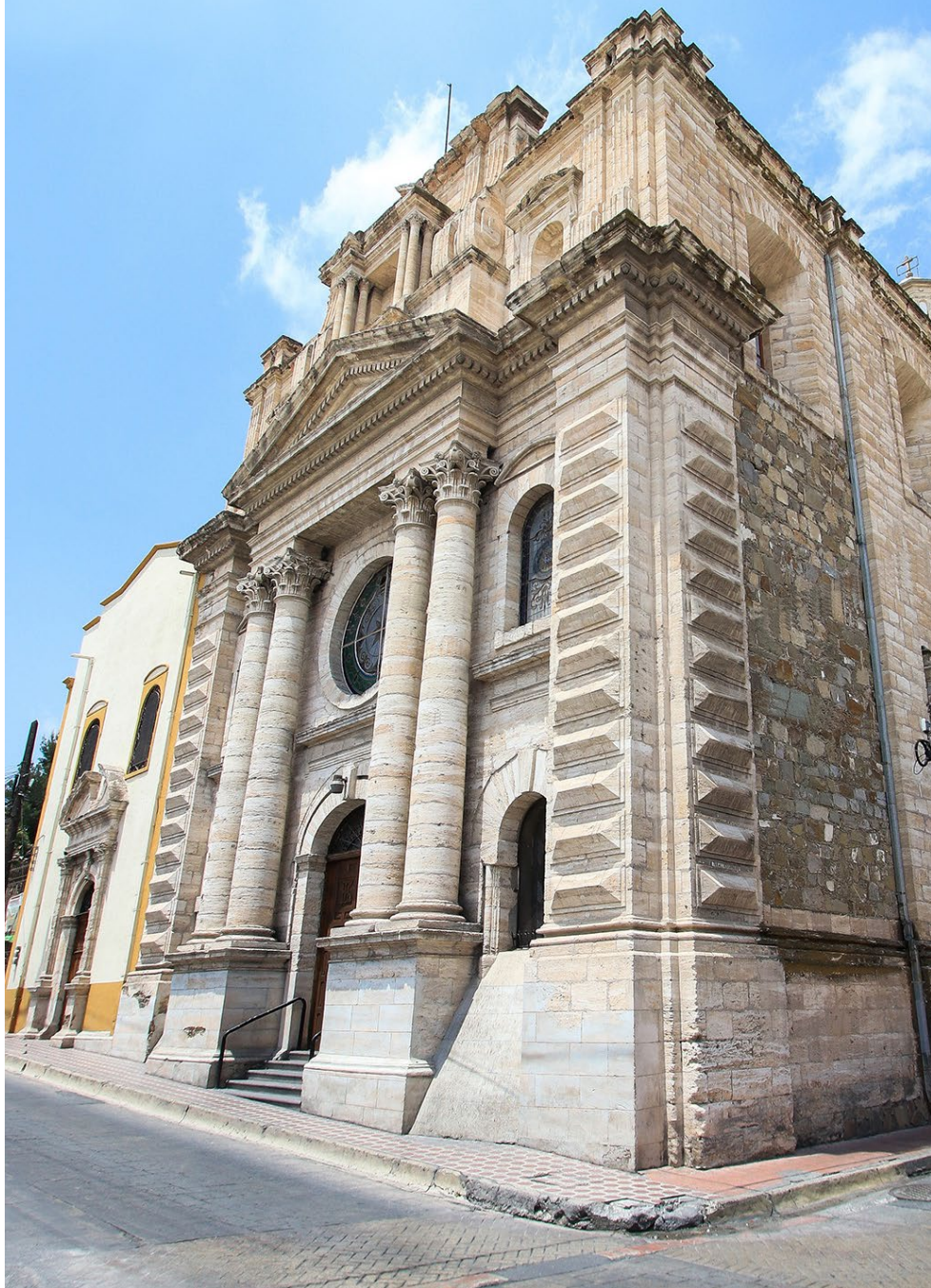
Vista actual de la iglesia, desde la calle Escobedo. Fotografía: Víctor Mendoza.
