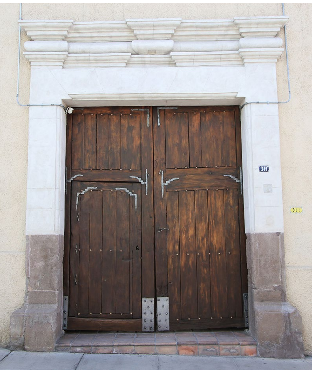
Puerta "La antigua", en su acceso por la hoy calle Bravo. Fotografía de Víctor Mendoza.
