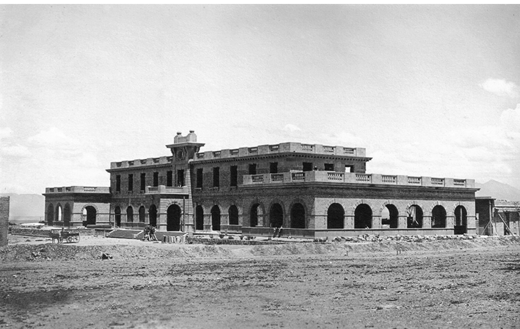
Construcción de la Estación de los Ferrocarriles Constitucionalistas. Saltillo, 1920. Foto: Alejandro. V. Carmona. Fototeca del AMS.
