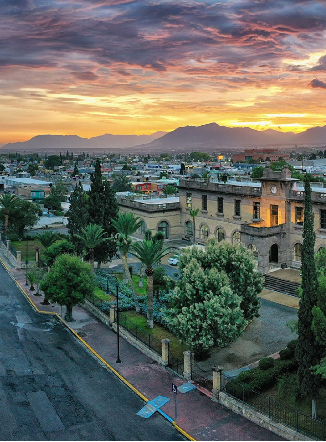
Vista panorámica del inmueble del Archivo Municipal de Saltillo. Fotografía: Daniel Bates Hurtado, 2020. Fototeca del AMS.
