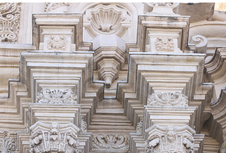
Fig. 6. Detalle de capiteles corintios, cornisas, entablamento y basas entre el primer y segundo cuerpo de la fachada principal.
