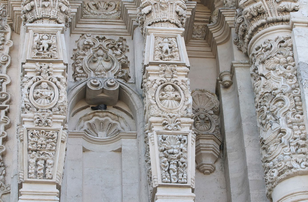
Fig. 4. Detalle del segundo cuerpo de la fachada principal (lado sur) con dos pilastras estípites y nicho intercolumnio.
