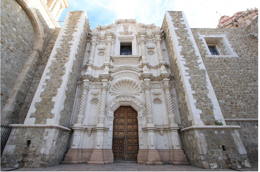
Fig. 11. Fachada sur de la catedral.
