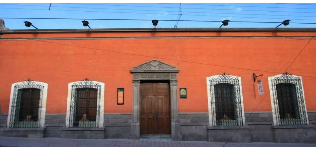
Imagen 9. Fachada principal del Museo Rubén Herrera, calle de General Cepeda 101. Centro Histórico. 2021.
