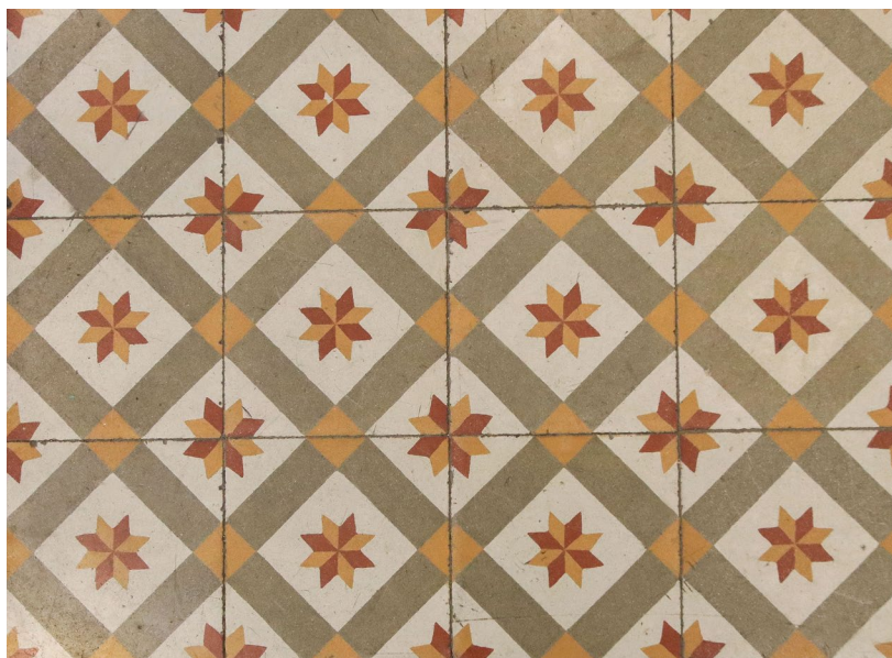
Detalle del piso de la cocina.
