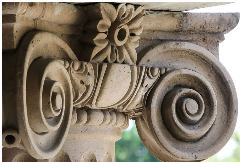
Detalle de las columnas de la entrada principal de la Escuela Normal de Coahuila.
